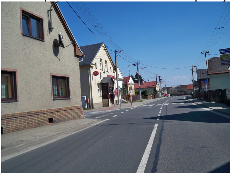
Obr. 8 Pohled na nepřehlednou křižovatku stávající silnice I/56 se silnicí III/46824 (ul. Bolatická)
