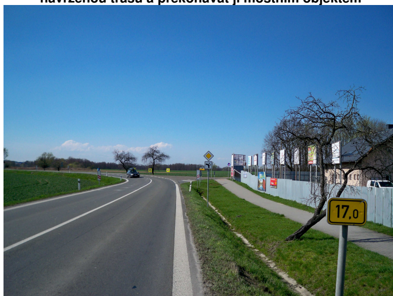
Obr. 12 Pohled ze stávající silnice I/56 (směr DB) na budoucí MÚK Kozmice
