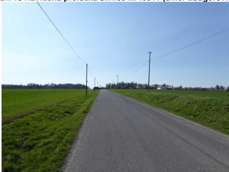
Obr. 19 Místo budoucího křížení navržené trasy s ul. Vrabloveckou, trasa zde prochází v hlubokém zářezu
