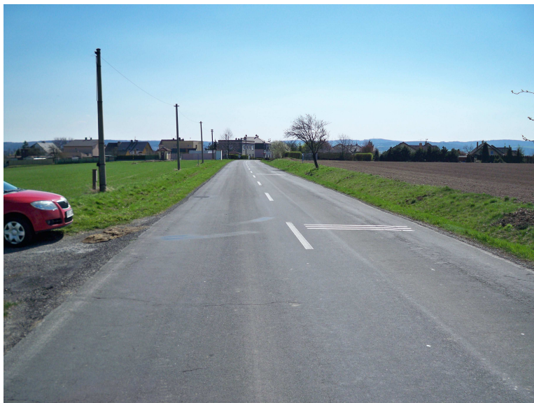
Obr. 1 Pohled ve směru od Chlebičova (silnice III/0468) na místo budoucí MÚK Velké Hoštice
