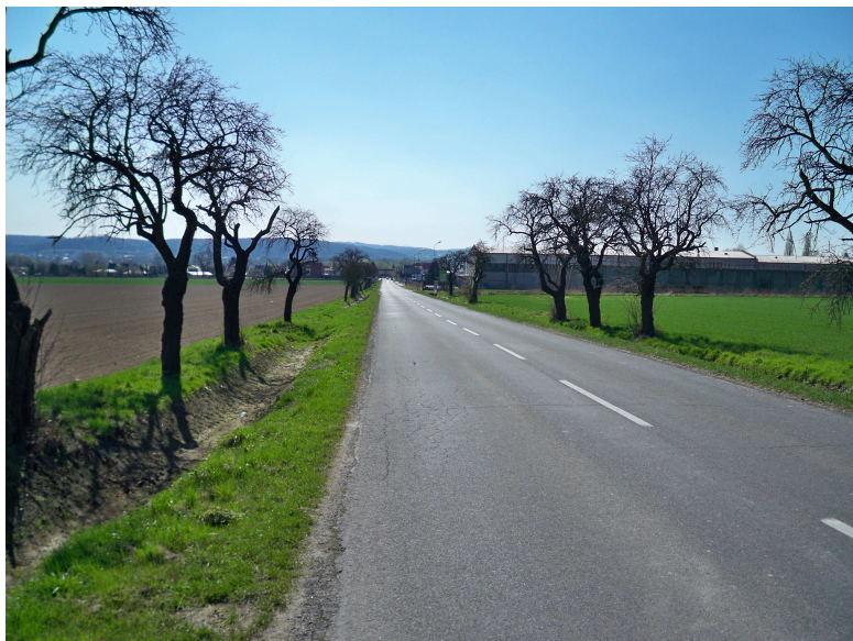
Obr. 7 Pohled na budoucí průsečnou křižovatku silnice III/46824 a přeložky silnice III/46824
