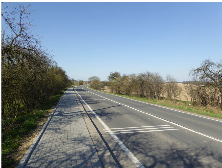
Obr. 13 Pohled ze silnice II/469 (směr Hať) na budoucí MÚK Hlučín
