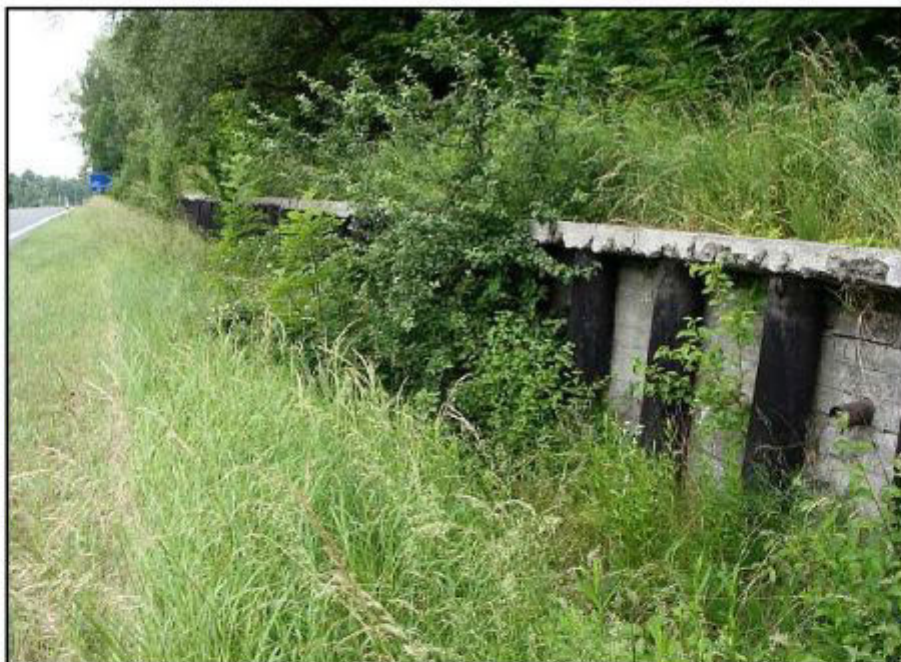
Obrázek č.9: Opěrná zeď s odvodňovacím prvkem na protější straně komunikace I/59
