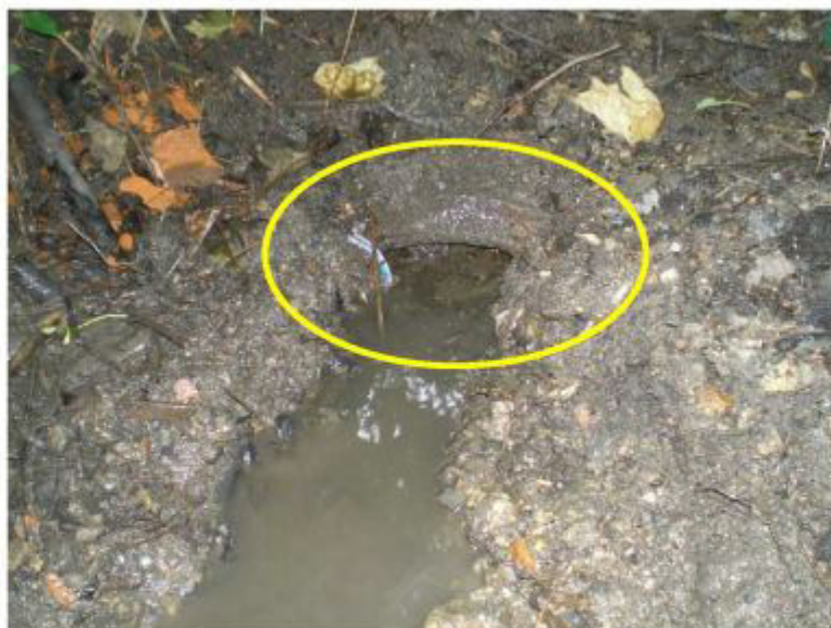
Obrázek č.3: Propust v místě vývěru Bezejmenného potoka
